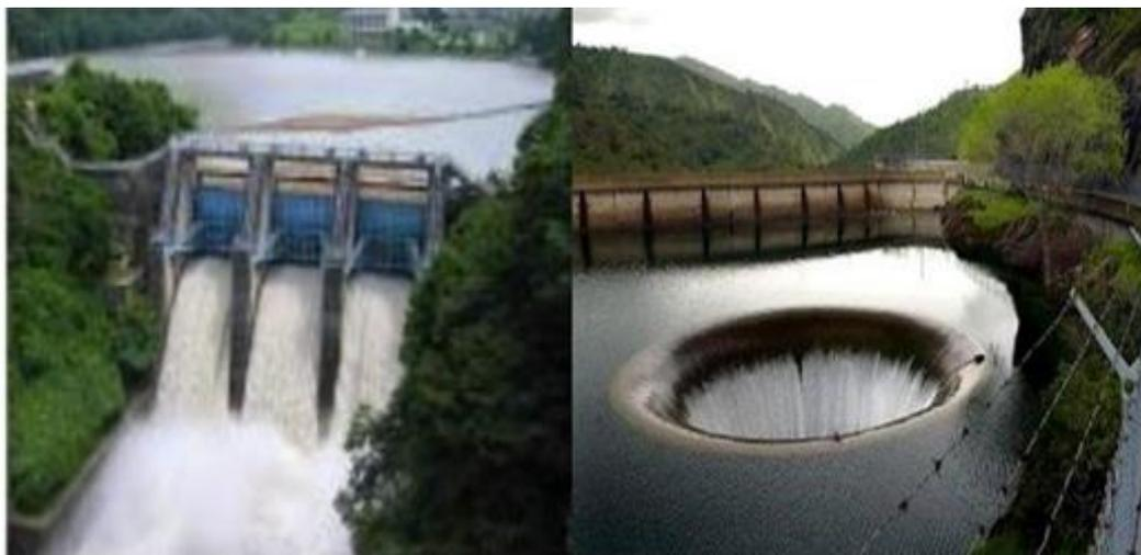
Figura 2 - Vertedouro com comportas e em Tulipa
